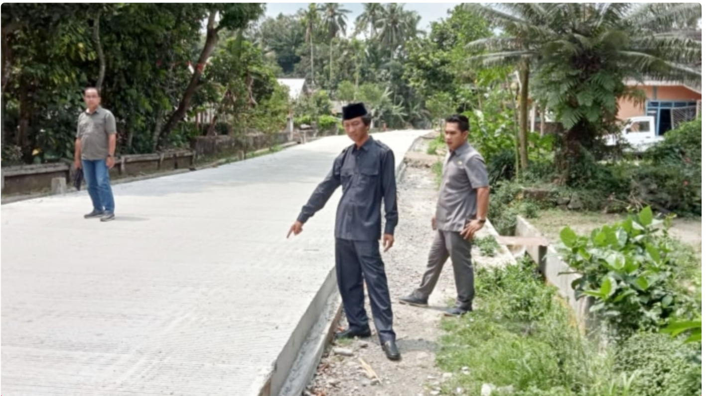
Ketua Komisi III DPRD Kabupaten Blitar, Sugianto saat sidak proyek jalan
